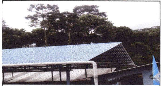
Foto 2: SE INSTALÓ LÁMINA ALUZINC TROQUELADA CALIBRE 26. VISTA DESDE EL PUNTO ESTE.
