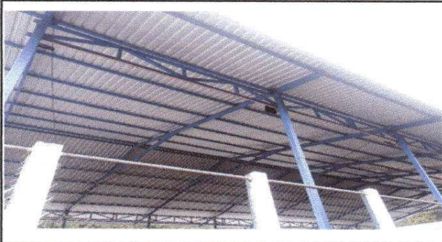
Foto 1: SE SUSTITUYÓ ESTRUCTURA SOPORTE DE METAL. VISTA PUNTO SUR.
